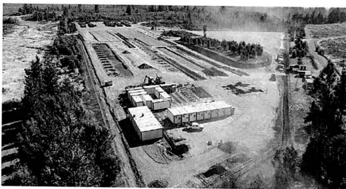
Prefabricación y suministro de piezas de hormigón armado para 61 torres de Parque Eólico San Rafael, Comuna de Renaico - Chile
