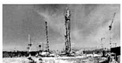
Pilotes CFA, bajo lodos y ensayos de carga, Aeropuerto Arturo Merino B.
