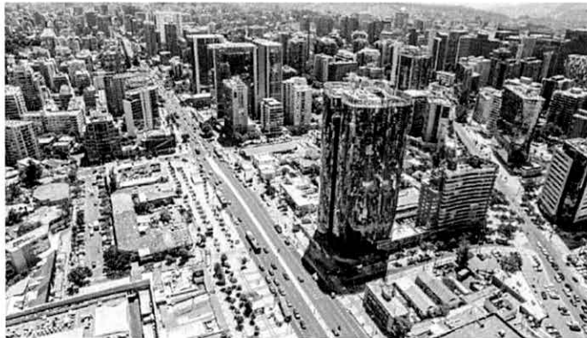
Edificio Apoquindo 5858, Santiago - Chile
