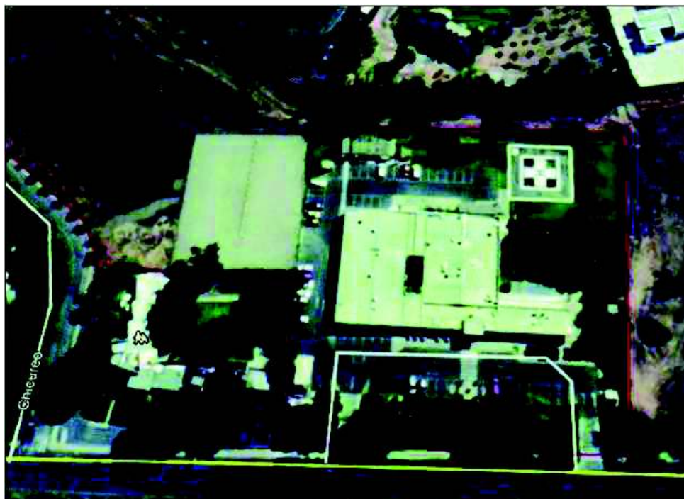
Imagen N° 4: Configuración de la edificación.
