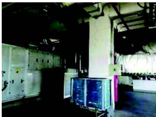
Fotografía N° 5: Manejadora de Aire.
