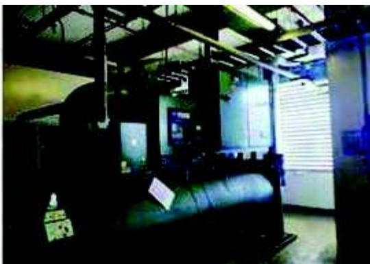
Fotografía N° 8: Chiller enfriado
