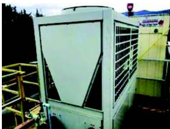
Fotografía N° 4: Bomba de Calor.
