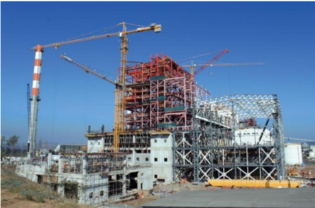
DETALLE: Montaje electromecánico de central termoeléctrica con capacidad para 240 MW
