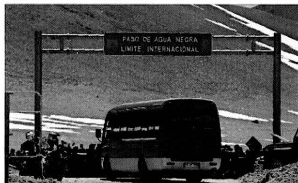
El Complejo Fronterizo Agua Negra se ubica a dos mil metros sobre el nivel del mar y atiende entre las 07:00 y las 17:00 para salir de Chile, y hasta las 22:00 horas para ingresar desde Argentina.
