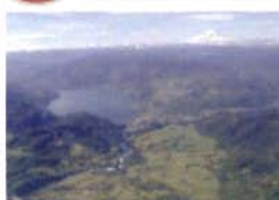
Planta hidroeléctrica, 490 MW
