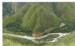
Planta hidroeléctrica, 188 MW
