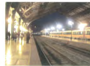
Nueva infraestructura férrea
