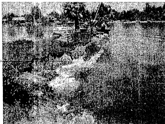
Muro de contención destruido tras el siniestro (vista derecha).
